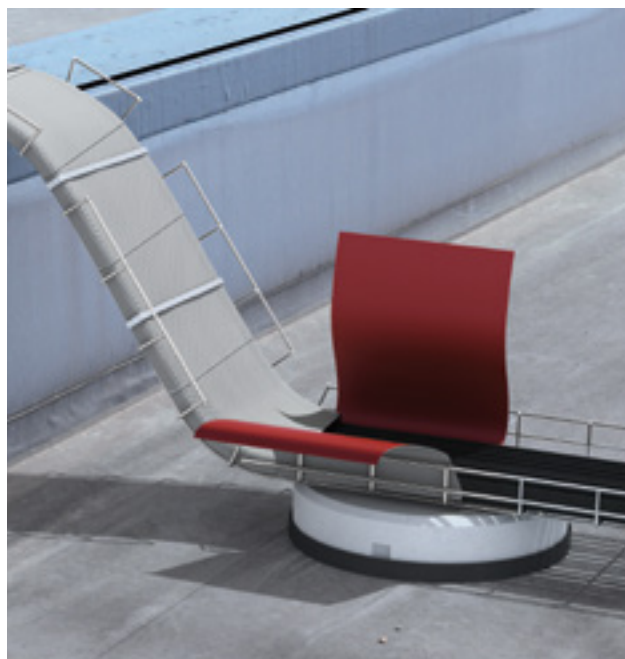
Brandschutzbandage zur Verhinderung der Brandübertragung
