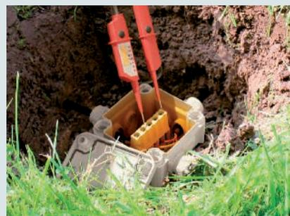
Die Anwendung ist denkbar einfach: Für kleinere Kabelabzweigkästen wird Aquasit einfach mit einer handelsüblichen Kartuschenpistole sauber vergossen, während Aquasit für größere Kästen in praktischen, passenden Mischbeuteln verarbeitet werden kann.
