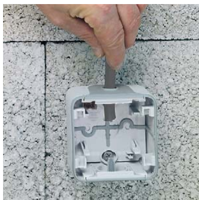
Kabel einführen
