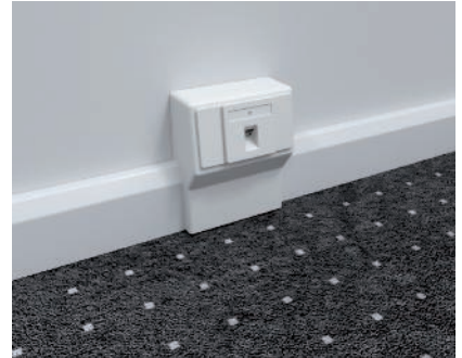
Fertig montierter Geräteträger.
