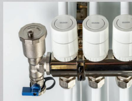
Das Raumthermostat steuert auch Stellantriebe (230 Volt), die im Heizkreisverteiler montiert sind.
