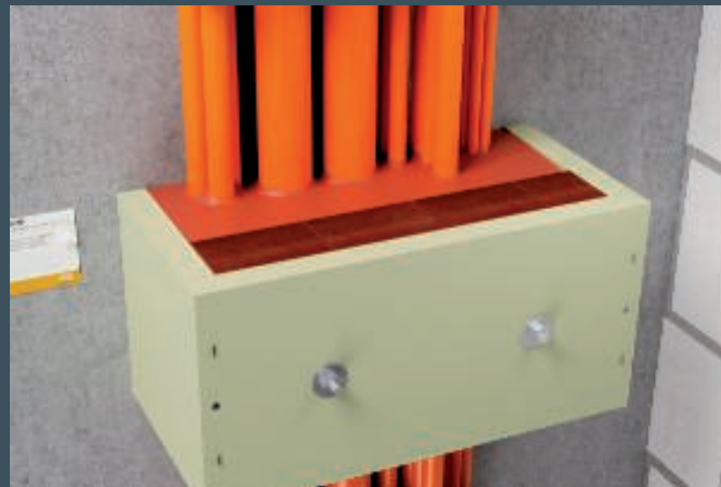
Fertig gefüllte Zugentlastung
