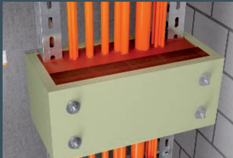
Fertig gefüllte Zugentlastung
