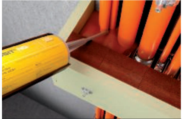
Befüllen mit Schaumstoffblöcken PYROPLUG® Block und Auffüllen der Kabelzwischenräume mit Brandschutzschaum PYROSIT® NG
