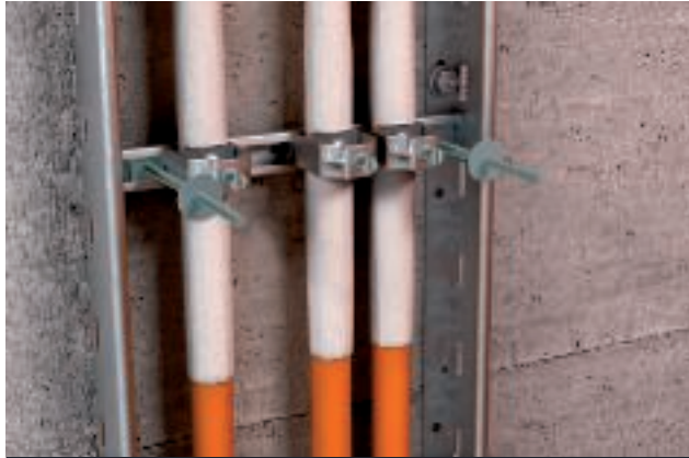
Beschichten der Kabel im Bereich der Zugentlastung
