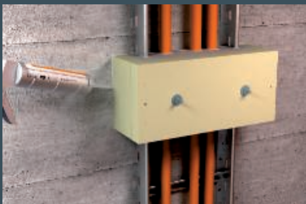
Verschließen aller Restfugen und versiegeln der Platten mit PYROCOAT® ASX
