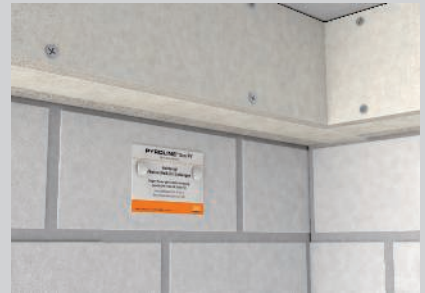
Kennzeichnung nach VDE-Anwendungsregel.
