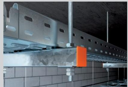
Anschluss der Gewindestange an der Montageschiene.
