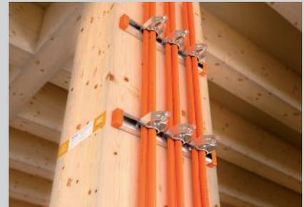
Senkrechte Kabelverlegung mit Schienen und Schellen am Holzbalken.
