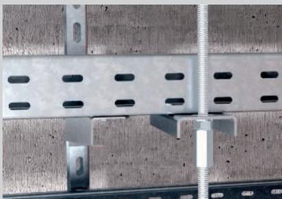
Gewindestangenbefestigung an der Kabelrinne bei mehrlagiger Anordnung.
