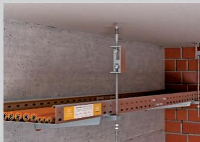
Deckenbefestigung der Gewindestangen mit Brandschutzbügel.
