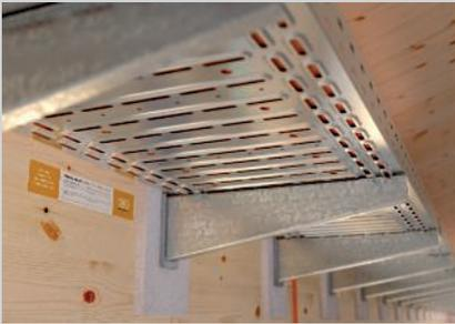
Auslegermontage seitlich am Holzbalken mit hinterlegter Brandschutzplatte.
