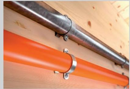
Kabelverlegung mit Einzelschellen und im Rohre seitlich am Holzbalken.
