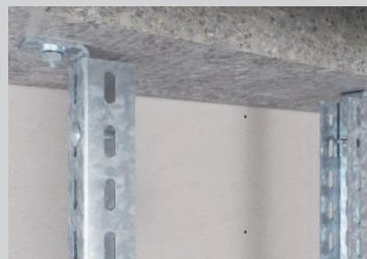
Deckenbefestigung der Leiterholme mit angeschraubten Montagewinkeln.
