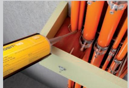
Befüllen des kompletten Gehäuses mit Brandschutzschaum PYROSIT® NG bei hoher Kabelbelegung.
