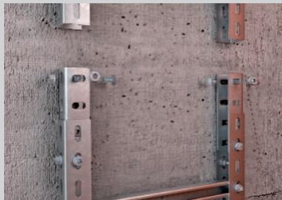
Stoßstellenausführung mit verschraubtem Verbinder.
