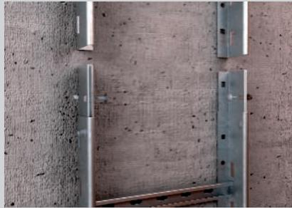
Stoßstellenverbindung mit verschraubtem Verbinder.
