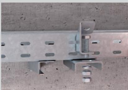
Befestigung des schrägen Anschlussbauteils.
