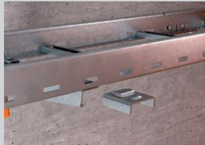
Aufstecken des Anschlussbauteils auf den Untergurt des Leiterholms.
