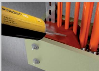
Auffüllen der Kabelzwischenräume mit Brandschutzschaum PYROSIT® NG.
