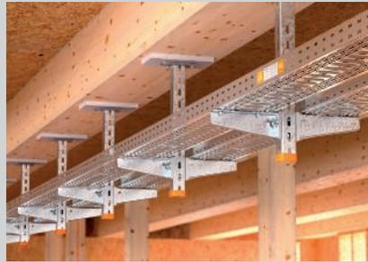
Hängestielmontage unter dem Holzbalken mit hinterlegter Brandschutzplatte.
