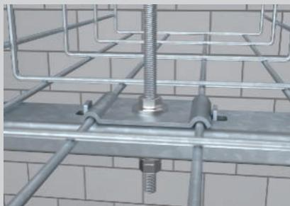
Positionierung und Befestigung des Klemmstucks mit der Gewindestange.
