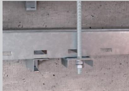
Befestigung der senkrechten Gewindestange am Anschlussbauteil.
