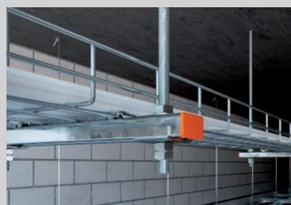
Anschluss der Gewindestange an der Montageschiene.
