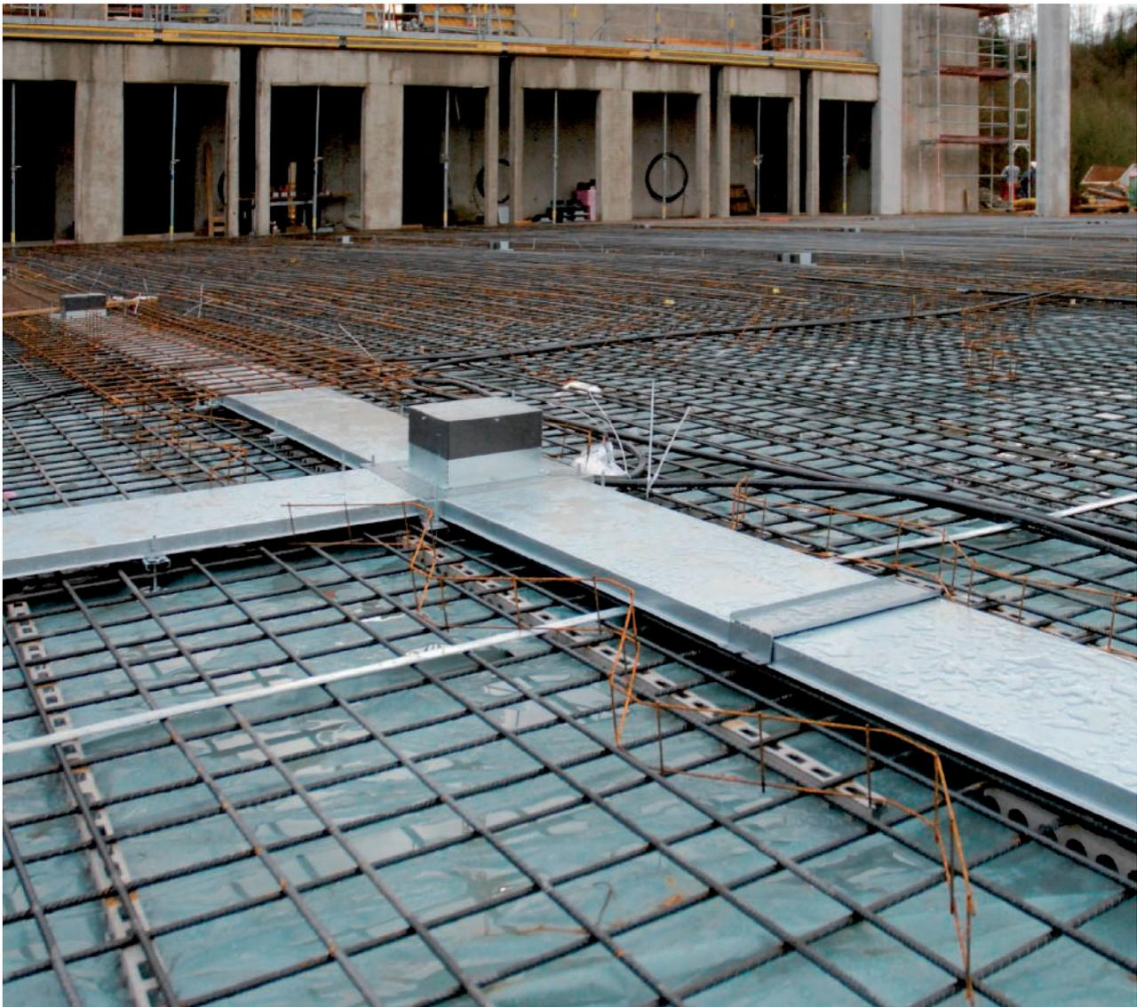
Montagefreundlichkeit, Robustheit und eine perfekte Einbindung in das Gebäude - das alles bietet das neue Im-Beton-System. Es ist abgestimmt auf neueste Entwicklungen und Trends in der Bauwirtschaft - auf die Technologie der Betonkernaktivierung genauso wie auf aktuelle Brandschutzrichtlinien.
