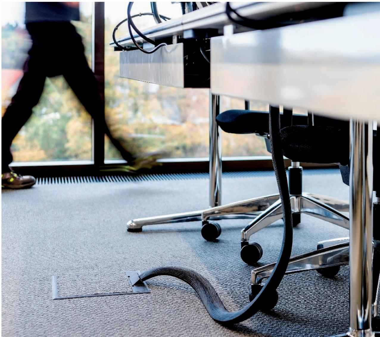
Geräteeinsätze versorgen Arbeitsplätze und andere Punkte mitten im Raum über den Boden mit Strom- und Datenanschlüssen. Es gibt Ausführungen für trocken und für nass gepflegte Böden, in runder und in eckiger Bauform. Als Materialien kommen Kunststoff oder Metall zum Einsatz. Geräteeinsätze eignen sich für den Einbau
