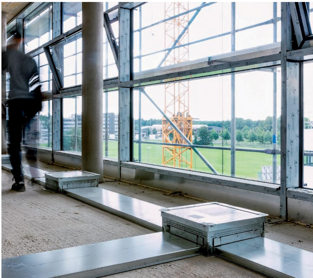
Das estrichüberdeckte Kanalsystem EÜK von OBO ist das ideale Elektroinstallationssystem für große Flächen mit festen Möblierungsplänen, zum Beispiel in Büro- oder Verwaltungsgebäuden. Kanalstrecken und Unterflurdosen bilden ein im Estrich verborgenes, engmaschiges Raster
