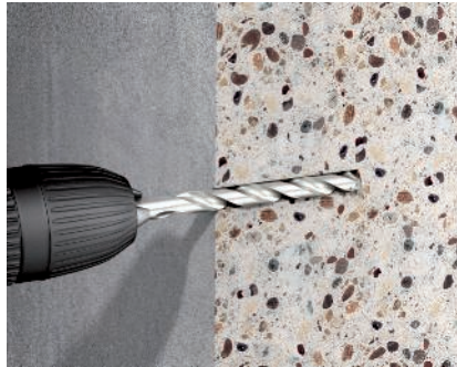
Bohren Herstellen einer Bohrung mit geeignetem Durchmesser.
