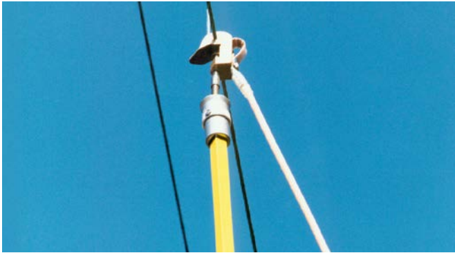
Einhängen der Fahrdrabt-Erdungsklemme in den Fahrdrabt.
