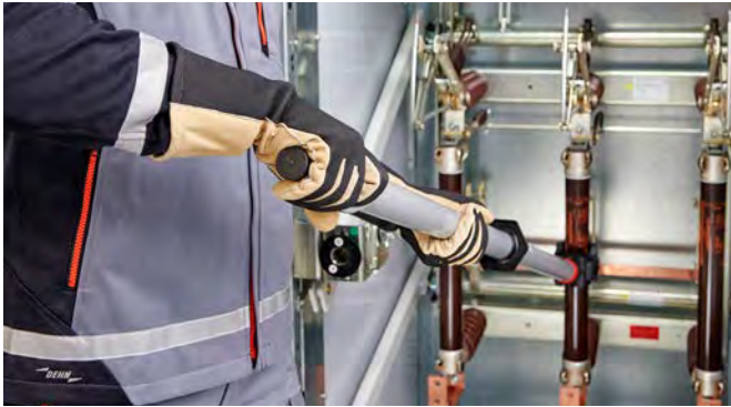
Betätigung eines NH-Aufsteckgriffes mit dem Schutzhandschuh.
