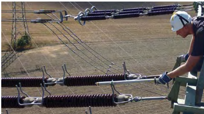
Hochspannungsanzeiger an einer 110 kV-Freileitung.
