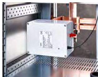
Löscheräte im eingebauten Zustand
