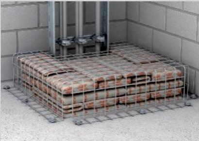
Sicherung gegen Abrutschen oberhalb des Fußbodens.
