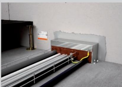
Potentialausgleich anschließen und Kennzeichnungsschild anbringen
