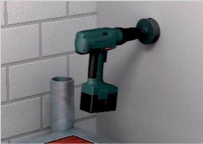
Bohren eines Lochs mit einem Dosenbohrer.
