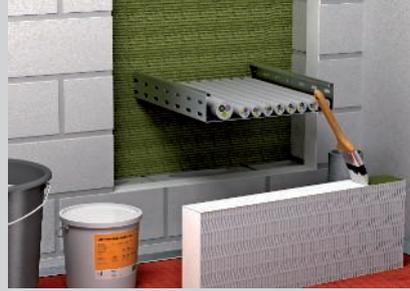
Bauteillaubung anfeuchten und Schnittkanten mit Beschichtung zum Einkleben versehen.
