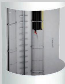
Bandagierte Steigetrasse im Turm einer Windkraftanlage.
